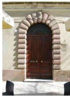
G) CORNICE DEL PORTONE CON CONCI BUGNATI IN PIETRE E CHIAVE DECORATA
