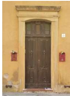
H) CORNICE DEL PORTONE MODANATA, TRABEAZIONE E ARCO RIBASSATO
