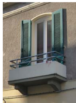
TIPO 8U) A DUE ANTE CON APERTURA A VASISTAS AD ARCO RIBASSATO
