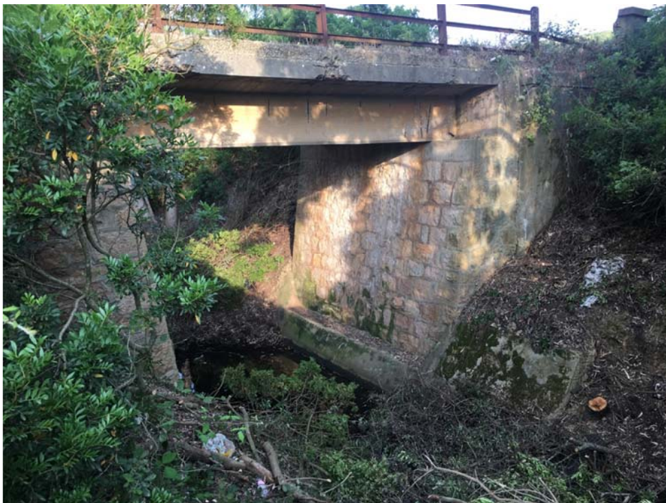
Figura 10 – attraversamento lato di monte
