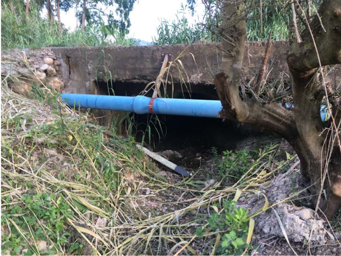
Figura 25 – Ramo Asta 78574 – attraversamento della SP 55
