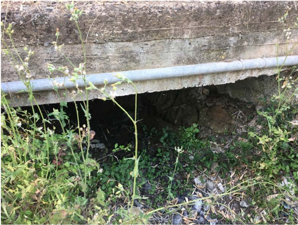
Figura 23 – Ramo Asta 71849 - attraversamento della SP 55
