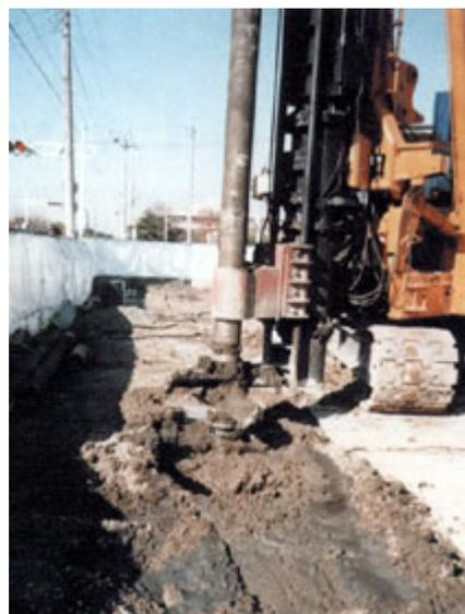
**Fig. 2 - Uso dell'Eco-cemento a rapido indurimento per consolidare terreni bagnati.**
