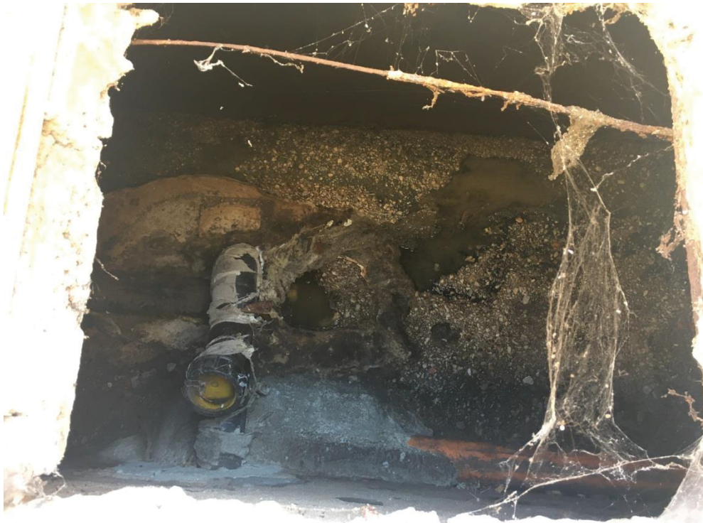
Tratto ispezionabile del canale lungo la Via Carducci
