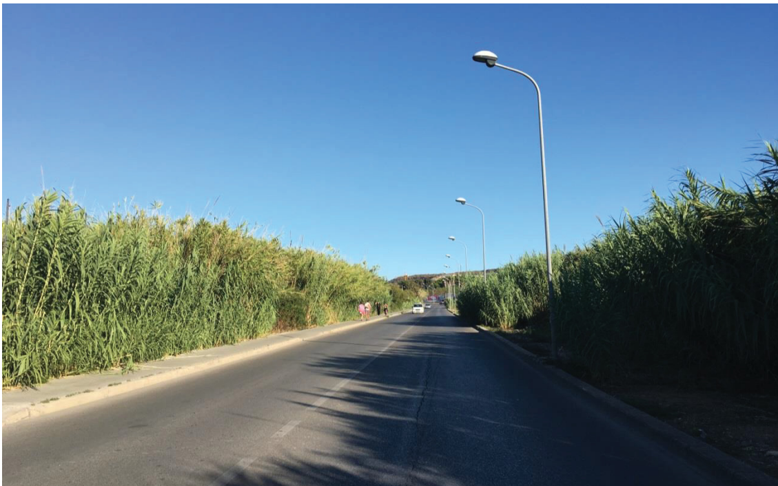
Tracciato sotto la viabilità urbana - Via Aldo Moro
