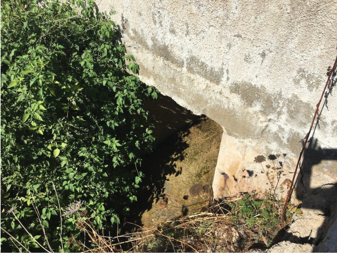
Sbocco nel versante costiero di Calabona al termine di via della Resistenza
