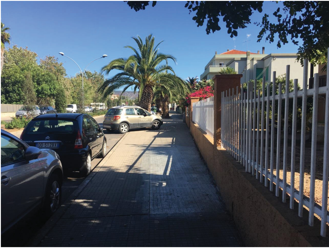
Tratto ispezionabile del canale lungo la Via Giovanni XXIII
