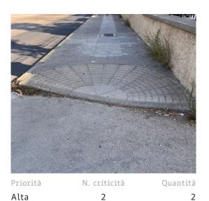
**E** - Demolizione di parte del marciapiede, realizzazione di rampa in continuità col marciapiede/percorso, priva di pendenza trasversale e con pendenza longitudinale <5% (max 8%). Segnaletica tattilo-plantare come da prescrizioni d'Abaco. Incluse demolizioni e ripristini.
